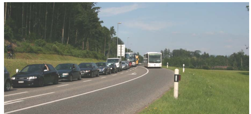
Beispiele aus Salzburg (Neutor) und der Schweiz: Dosierstelle und elektronische Busspur
